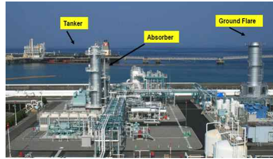
[그림 9-41] 선박에서 원유 하역 과정에서의 VOCs 흡수·회수 및 고온 산화 처리
