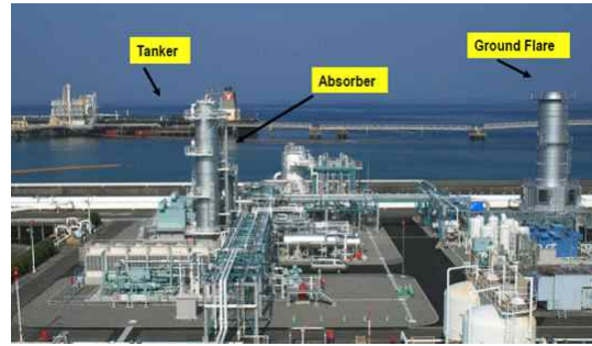
[그림 2-42] 선박에서 원유 하역 과정에서의 VOCs 흡수·회수 및 고온 산화 처리
