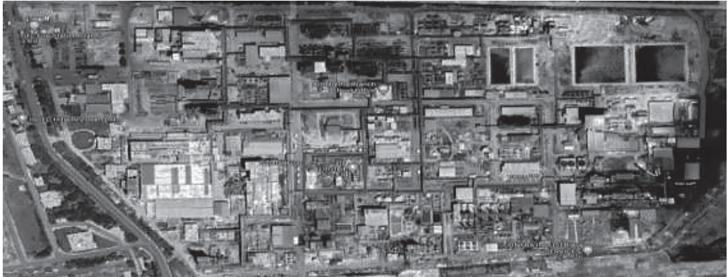
| 그림 10. 구자라트 플루오르 케미컬 공장 위성사진 |
